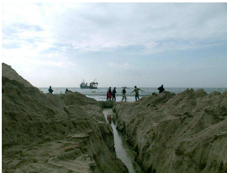
Figure 2.2 – Déploiement du câble électro-optique sur la plage des Sablettes, à La Seyne-sur-Mer (octobre 2001).
